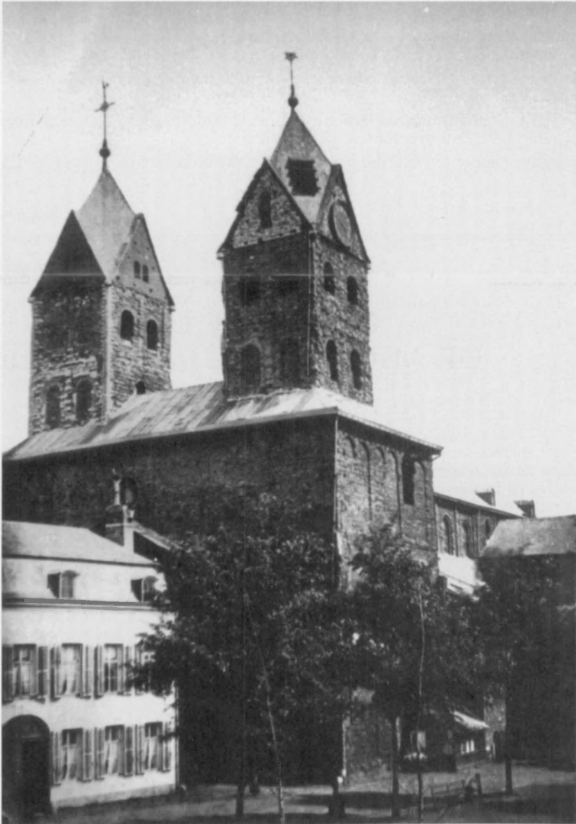
Fig. 1. — Eglise avant restauration des deux tours en 1876 Cliché architecte Bourgault (I.A.L.)
